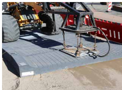
Versetzen eines MONODUR®-Kreisverkehrs mit halbseitiger Verkehrsführung
