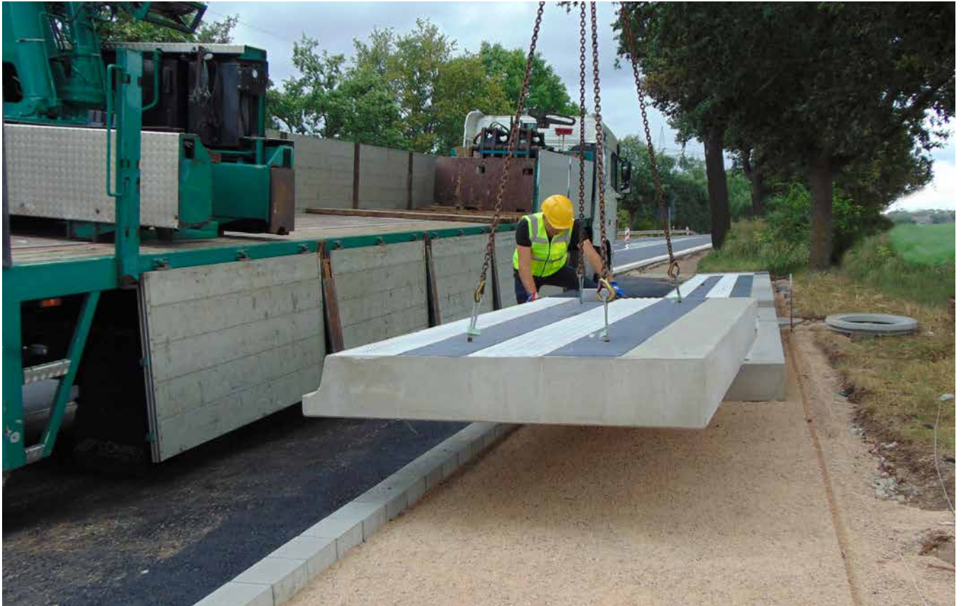
MONODUR®-Bushaltestelle mit integrierten barrierefreien Elementen
