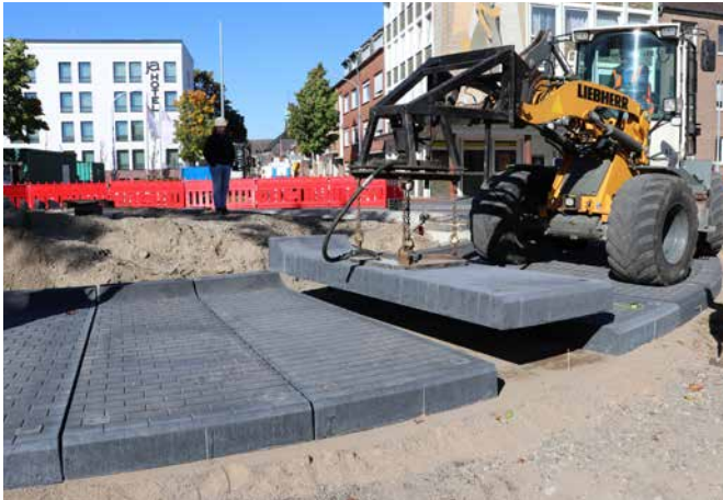
Verlegung der MONODUR®-Fertigteile
