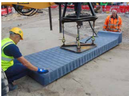
Schnelles Versetzen der vorgefertigten Segmente
