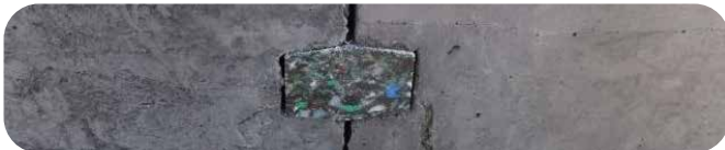
Kopplungsverbinder zwischen den Platten
