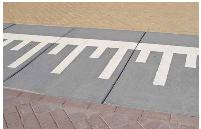
Rampe Tempo 30 mit Anti-Rutsch-Struktur
