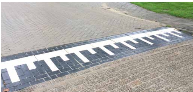
Rampe Tempo 30 mit Pflasterstruktur
