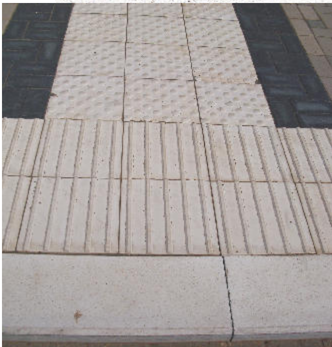
Richtungsfeld aus Rippenplatten und Aufmerksamkeitsstreifen aus Noppenplatten
