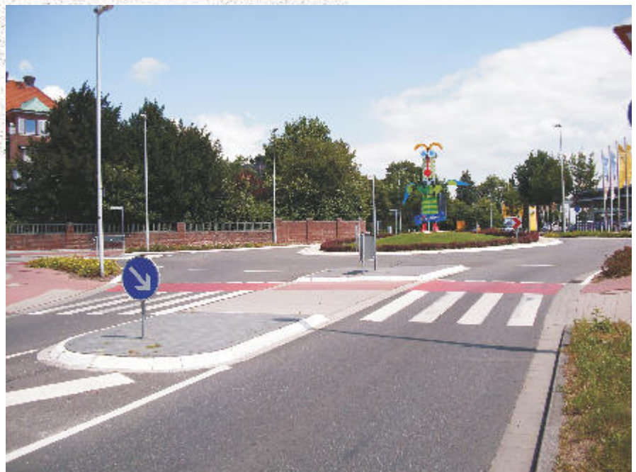
48282 Emsdetten, Elbestraße, Kreisverkehr
