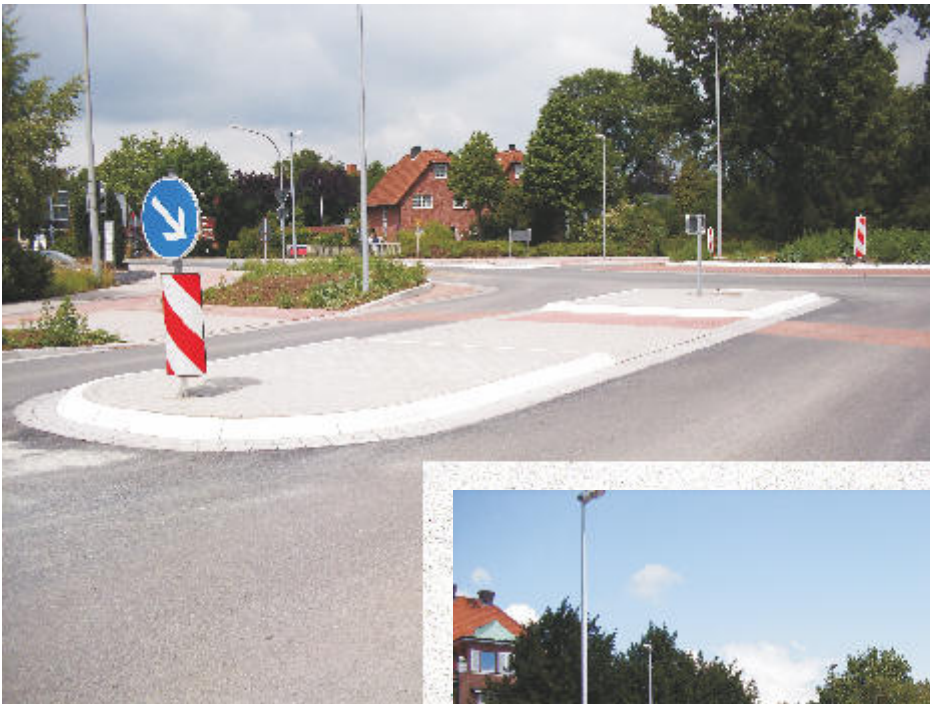
48317 Drensteinfurt, Hammer Straße, Kreisverkehr
