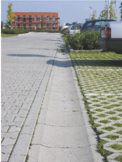
48155 Münster, Martin-Luther-King, Industrieobjekt
