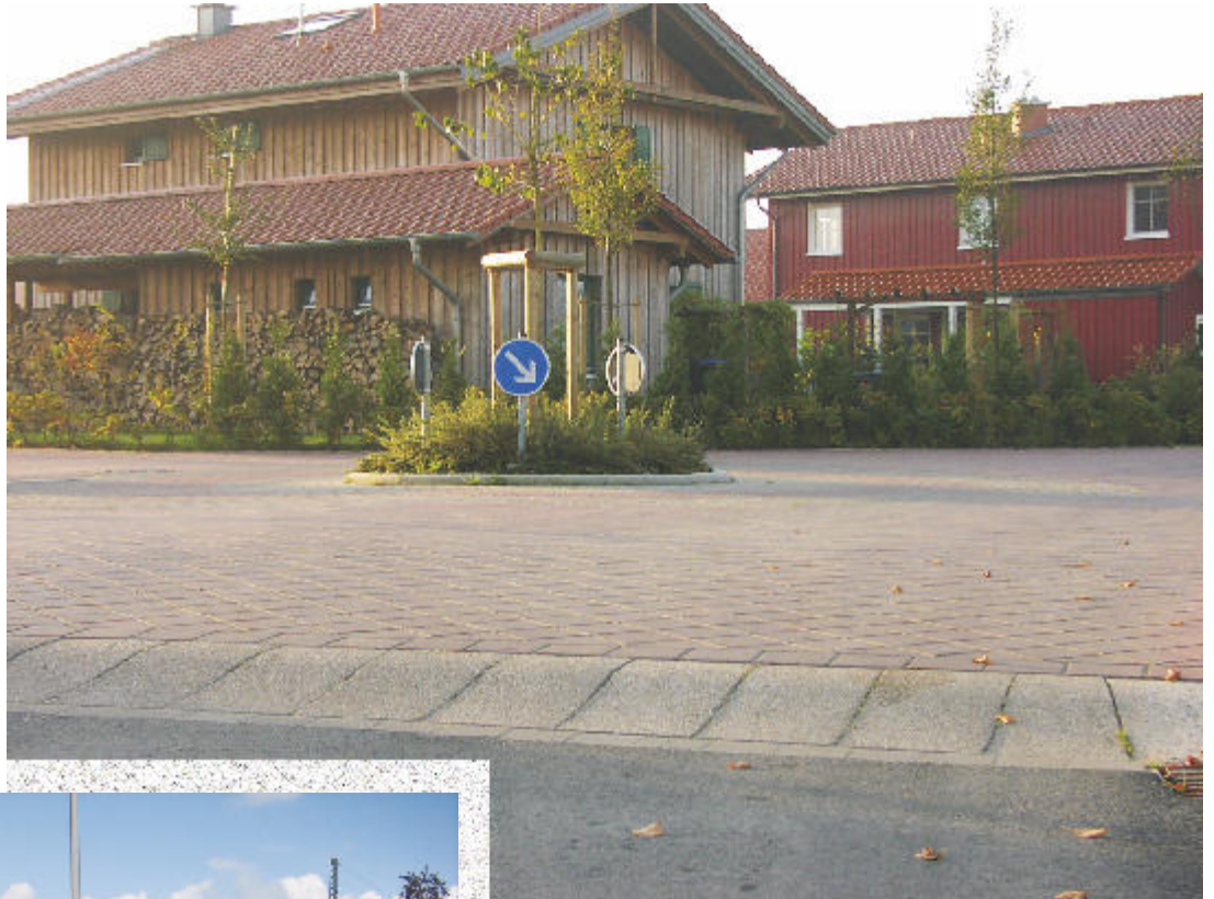
48727 Billerbeck, Baugebiet Oberlau II
