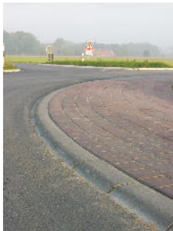
48727 Billerbeck, Baugebiet Oberlau II
