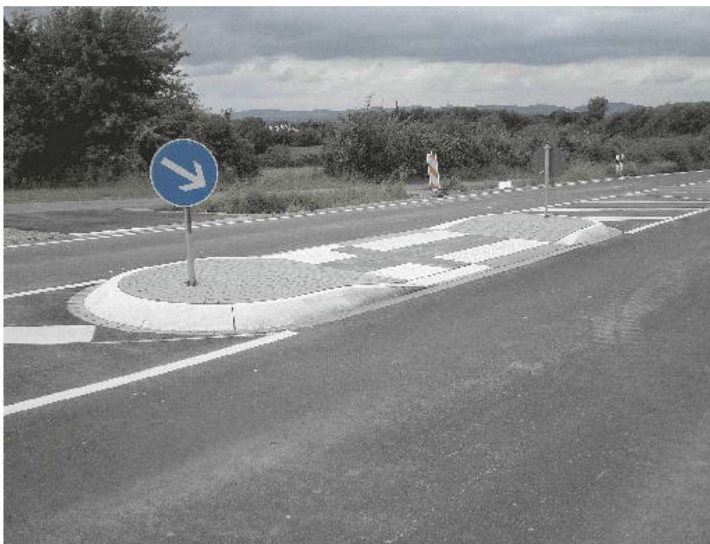
Querungssinsel außerorts mit Tastbordauftritt 3 cm, Fahrbahnteiler ausgepflastert.
