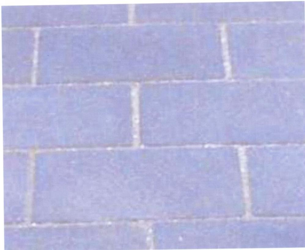
Bild Nr. 4. Ansicht der Pflasterfläche mit Sand-Brechsand-Fugenverfüllung
