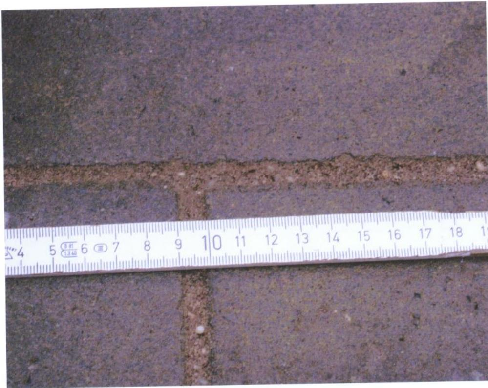
Bild Nr. 3. Ansicht der Pflasterfläche mit Natursand-Fugenverfüllung
