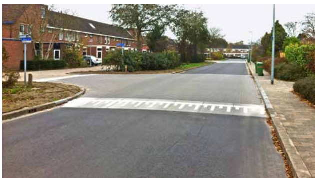
Rampe Tempo 30 mit Anti-Rutsch-Struktur
