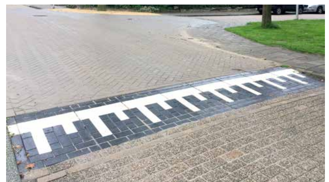
Rampe Tempo 30 mit Pflasterstruktur
