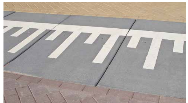
Rampe Tempo 30 mit Anti-Rutsch-Struktur
