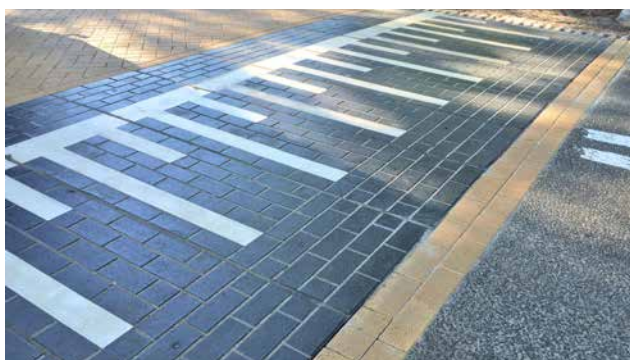
Rampe Tempo 50 mit Pflasterstruktur
