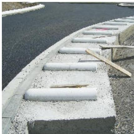
Die Anfahrschwelle wird in den Frischbeton integriert
