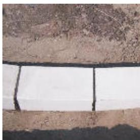
Die Bordsteinverfugung mit Bitumen oder PU-Dichtmittel kommt auch bei dem anspruchsvollen Bau von barrierefreien Querungsstellen mit Tast- und Rollbordsteinen immer häufiger zum Einsatz. Weitere Vorteile - neben den Pflegekosten - liegen hier in dem Schutz der Bordsteinstöße in den Fugen und in dem Verschließen der nicht zu vermeidenden Keilfugen im Kurvenbereich.
