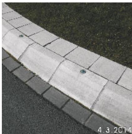
Bordsteinfuge mit hellem Polyurethan-Dichtmittel
