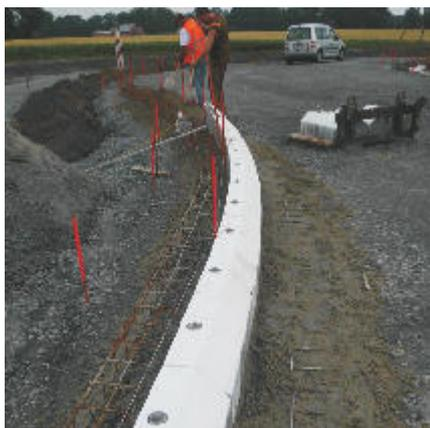
Betonfundament mit Bewehrung und geschalter Rückenstütze
